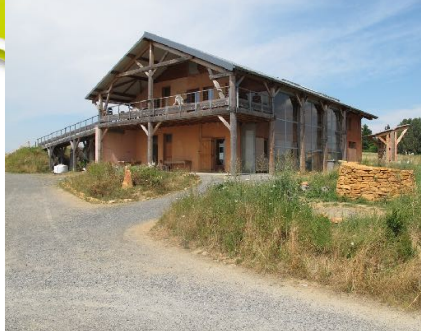
Ecocentre du Lyonnais, La Tour de Salvagny
